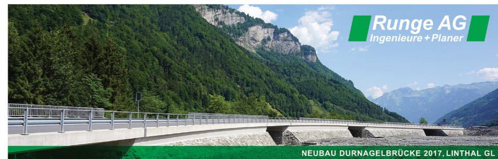
NEUBAU DURNAGELBRÜCKE 2017, LINTHAL GL
